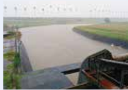
かき原地区排水機場
