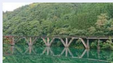
日之影町八戸ダム上流に架かる旧五ヶ瀬川第三橋梁。昭和14年完成、長さ268m、日本初の連続V型鉄筋コンクリート橋
