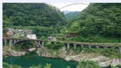
日之影町と延岡市の境にある綱ノ瀬(つなのせ)川に架かる旧綱ノ瀬橋梁。昭和12年完成、長さ418mで、43のアーチが重なる鉄筋コンクリート製のアーチ橋
