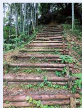
遊歩道・階段の整備
